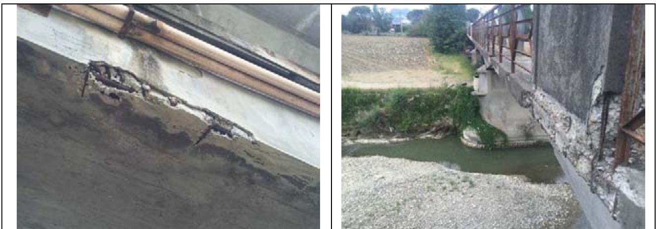
**Presenza di ferri di armatura esposti (assenza di copriferro)**
