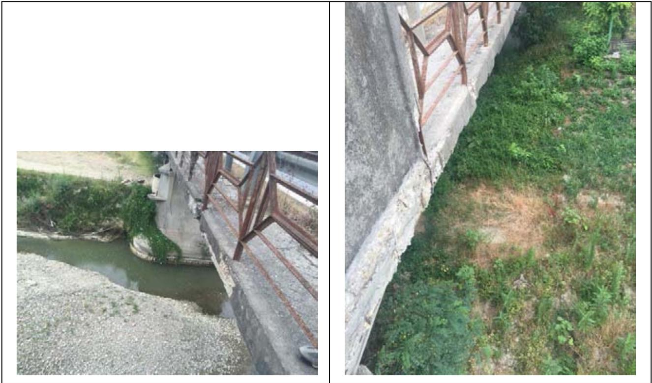
**Degrado dello sbalzo di carreggiata (marciapiede) con evidenza di ferri esposti e cls ammalorato**
